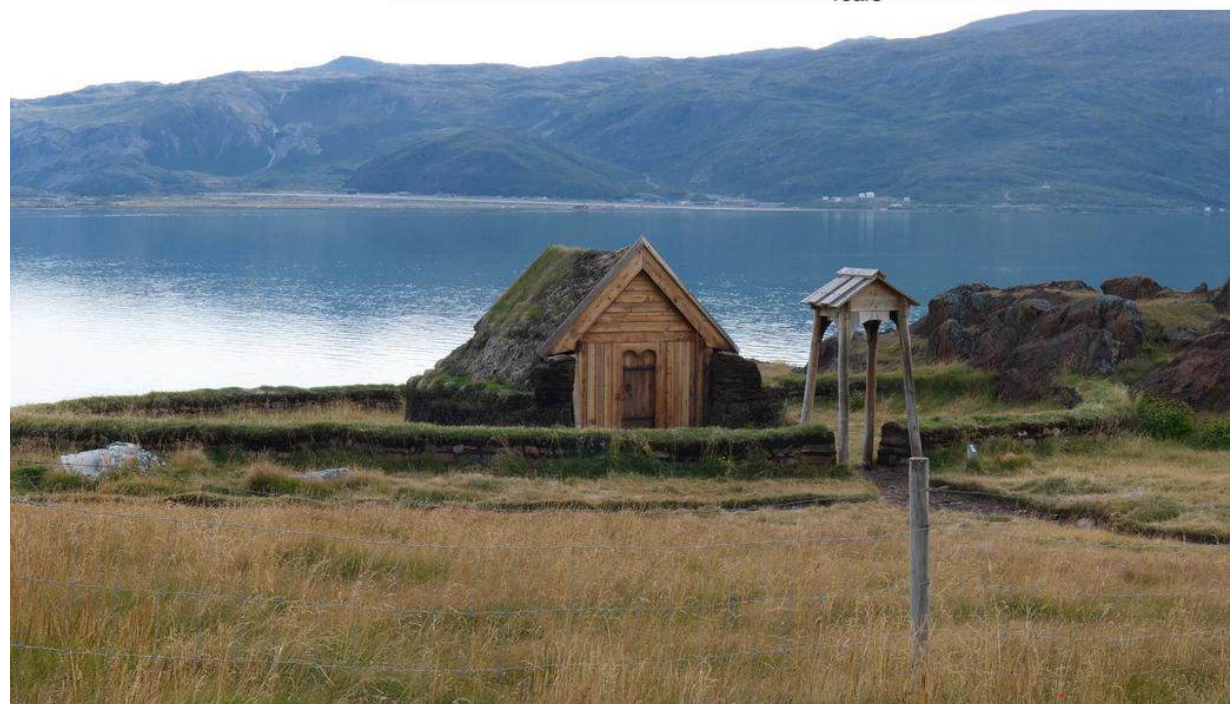
Église reconstruite à Brattahlíð, Groenland
